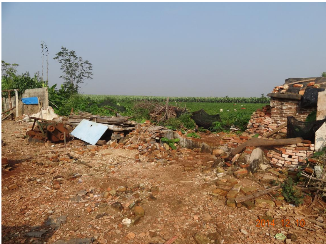
上图为龙门林场青锋林队被台风吹倒的围墙
